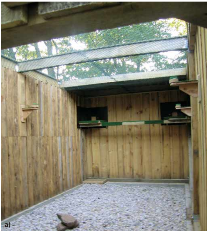
Abb. 1 Ganzseitig geschlossene Voliere zur Haltung eines Falken-Zuchtpaares. a) Hinterer Teil. Zu beachten sind: versetzte Anordnung der Wandbretter (ermöglicht Luftzirkulation), doppelter Draht als obere Abdeckung zur Vermeidung von direktem Wildvogelkontakt, Teilüberdachung der Voliere insbesondere im Bereich der Nistplätze mit Sitzmöglichkeiten unter Dach, zwei Nistplätze zur freien Horstwahl, seitliche Sitzmöglichkeiten nicht überdacht, Kies als Bodengrund auf Naturboden. Wände stehen auf einem 80 cm tiefen Betonsockel, um den Zugang von Nagern und Prädatoren durch Graben zu verhindern. b) Vorderer Teil: Sonnendeck (oben rechts; verhindert das Koten ins Wasser), überdachte Sitzmöglichkeit, von außen mittels Klappe direkt zugängliche Bademöglichkeit (unten rechts), wasserdurchlässiges Futterbrett, von außen über eine Klappe zu bedienen.
